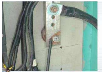
อันตรายจากการต่อสายไฟที่ไม่ใช้หางปลา
